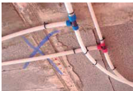
Installations sanitaires avec tuyau PEX.
